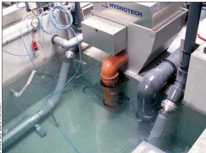
Sedimentfilter: Die Trommel sibt Feststoffe ab.
